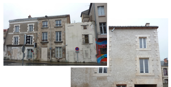
10, rue St Cyprien / 64, Boulevard A. France
